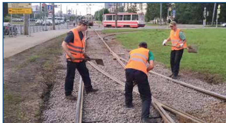
Бойцы стройотряда «Монтёры пути» за работой
